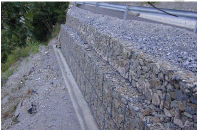
Figura 3—Intervento di consolidamento sottoscampa stradale
